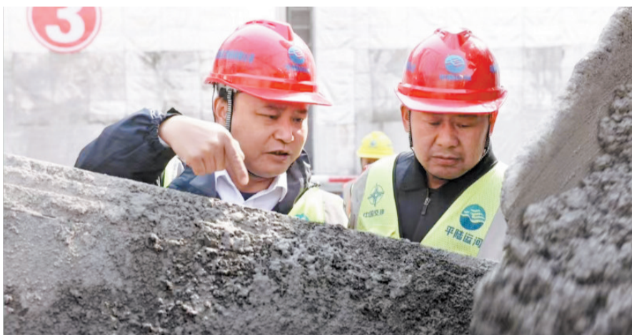
黄海波(左)检查工地施工情况。均 本报记者 赖昕 通讯员 杨怀鹏 摄
