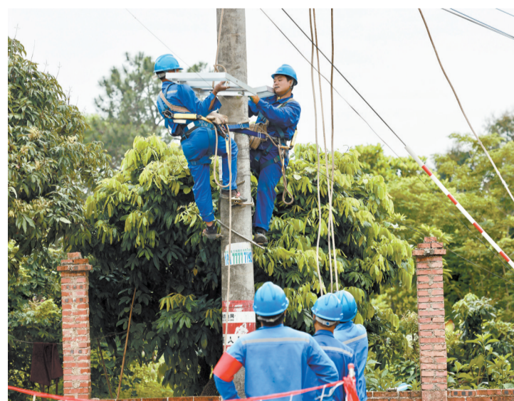
工作人员安装自动化开关。许裕 摄
